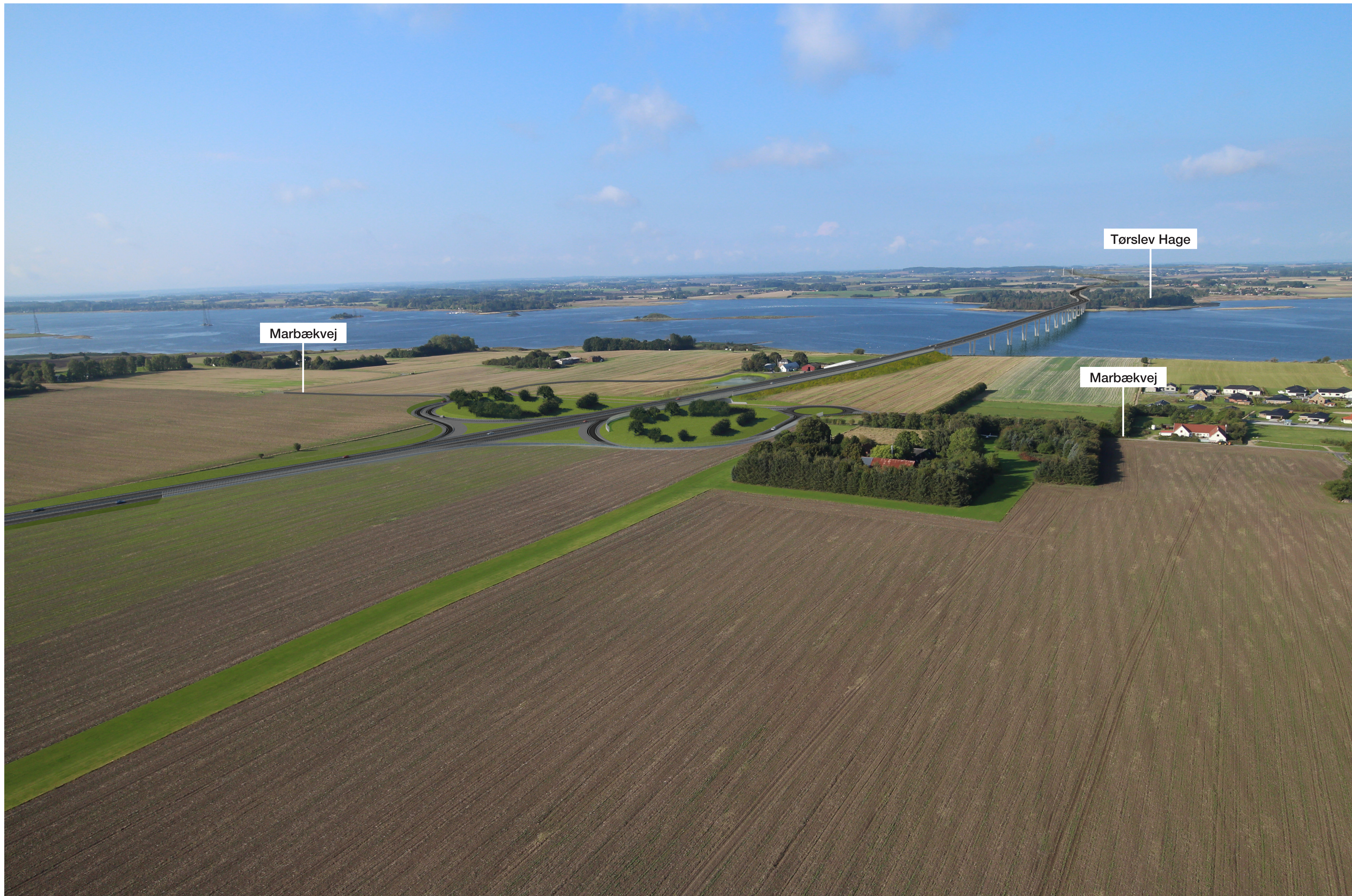
Tilslutningsanlæg ved Marbækvej
