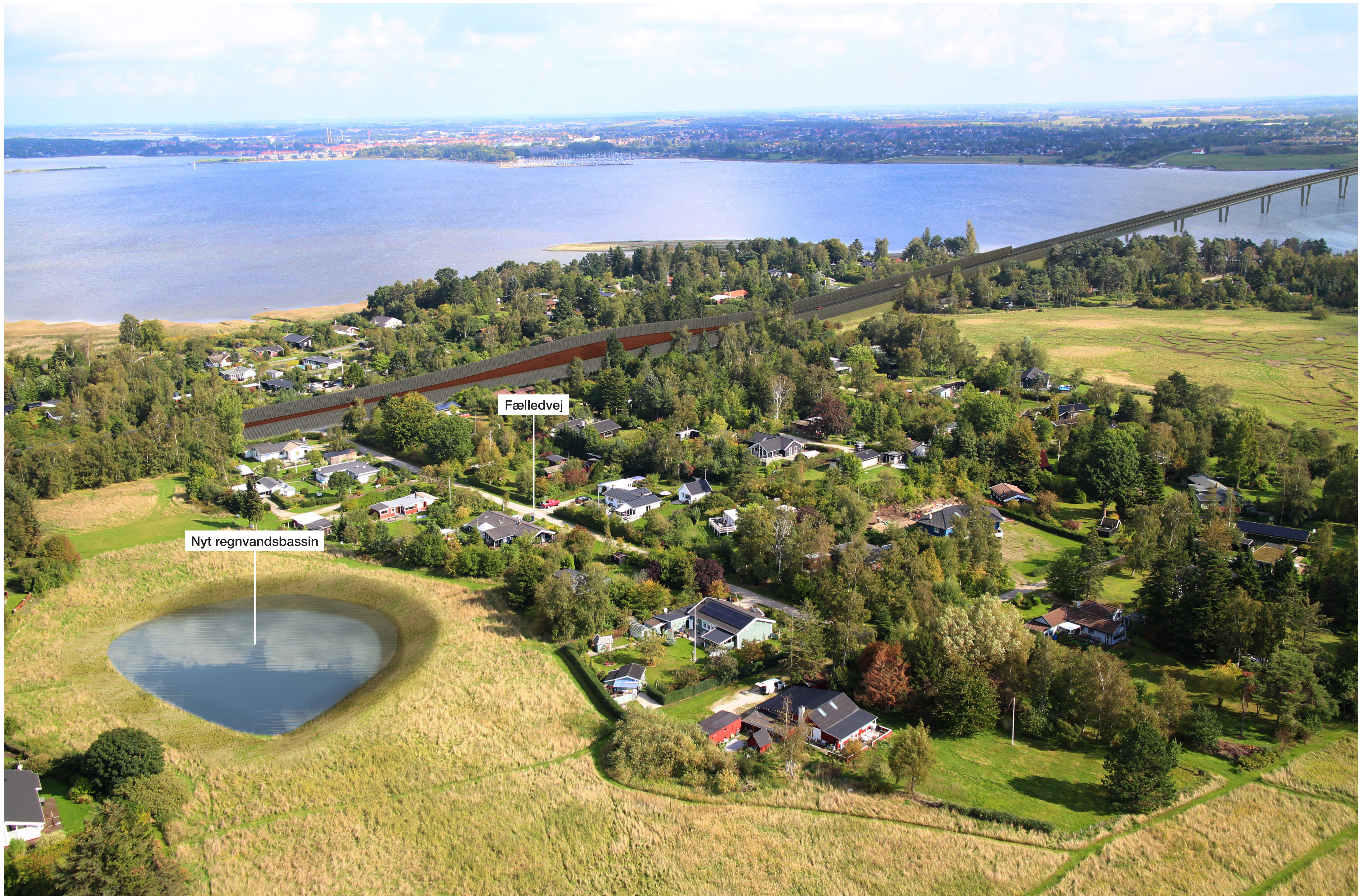
Vejanlæg med støjskærme igennem Tørslev Hage
